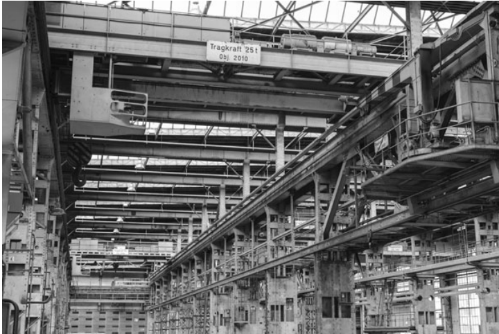
Alte Industriestandorte bergen Potenzial für neue Nutzungen. Foto: graustufen
