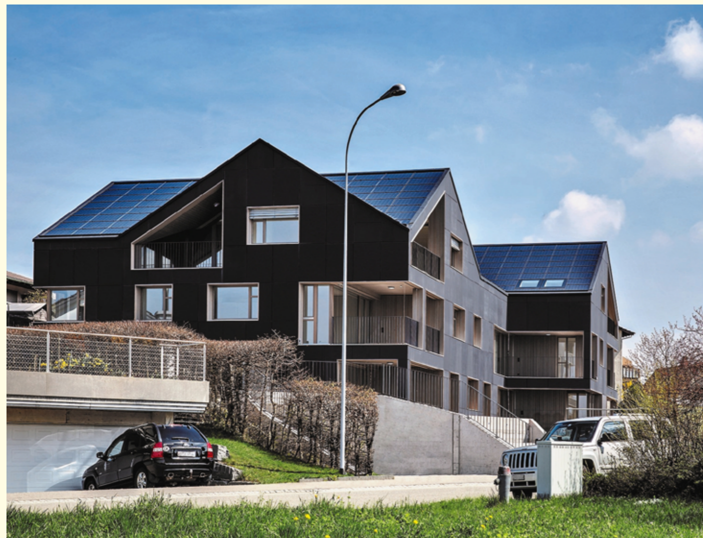
Meilenstein für das nachhaltige Wohnen: Das erste energieautarke Mehrfamilienhaus der Welt ohne Netzanschlüsse steht in Brütten ZH.
